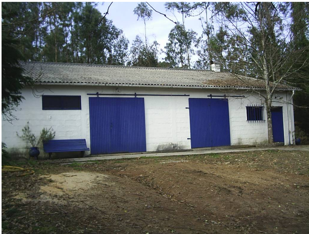
Fotografia 4 - Edificação de apoio agrícola/armazenagem, afectada pelo Ramo A+B e pelo Ramo C do Nó de Sandim
